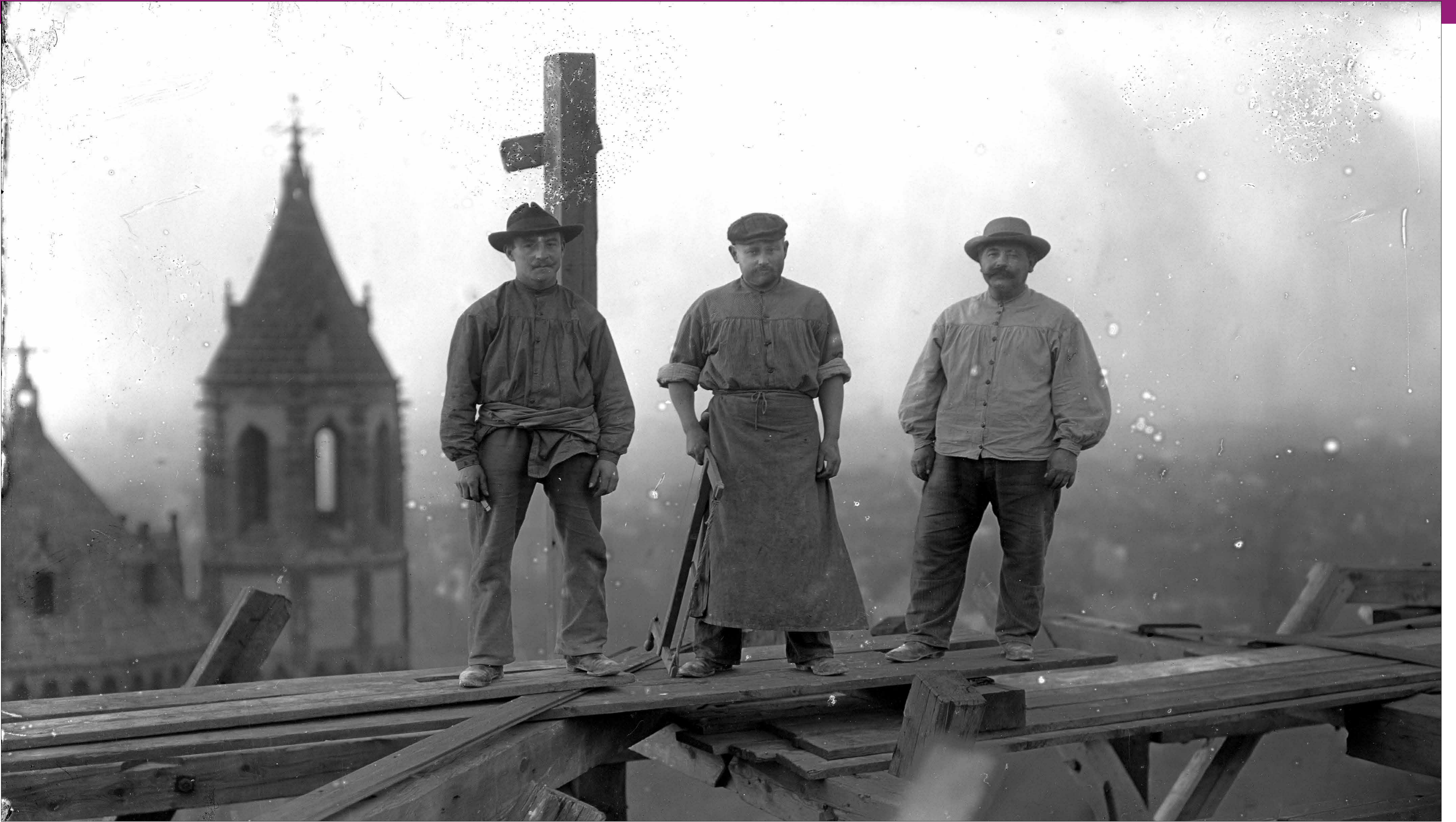
Arbeiter auf einem Gerüst am Dom, um 1909 @ Stadtarchiv Worms 00903
